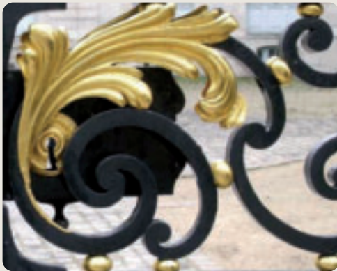
Restauration du portail de l'Hôtel Dieu à Troyes finition à la feuille d'or
